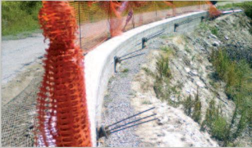
L'intervento riguarda quattro dissesti. Sui primi tre è stata realizzata una paratia di micropali per sostenere un cordolo in cemento armato atto al contenimento della strada e una serie di tiranti per ridurre le sollecitazioni flessionali del terreno. Bisogna ancora installare la barriera stradale e fare i rappezzi in asfalto nelle aree scavate.
